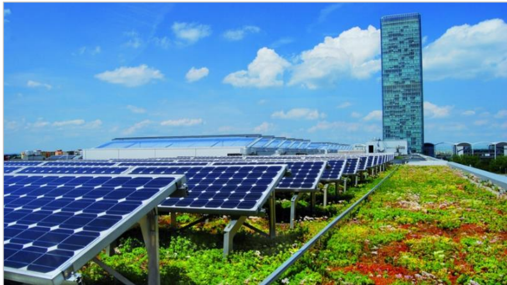
Abbildung 4-2: Beispiel für die Ausführung der Beckenabdeckung als Gründach mit Photovoltaikpanelen
